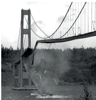
а) разрушение моста в 1940 г.
